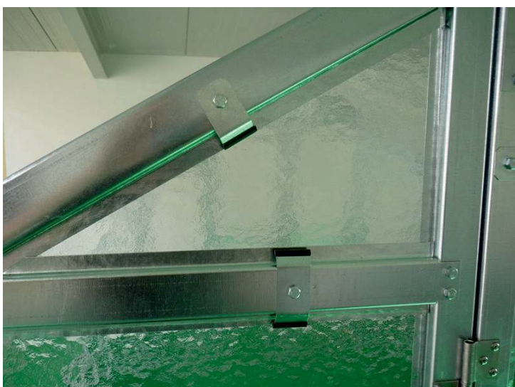
Přichycení skla k pozici 72 příchýtkou 83-1 a 83-2
