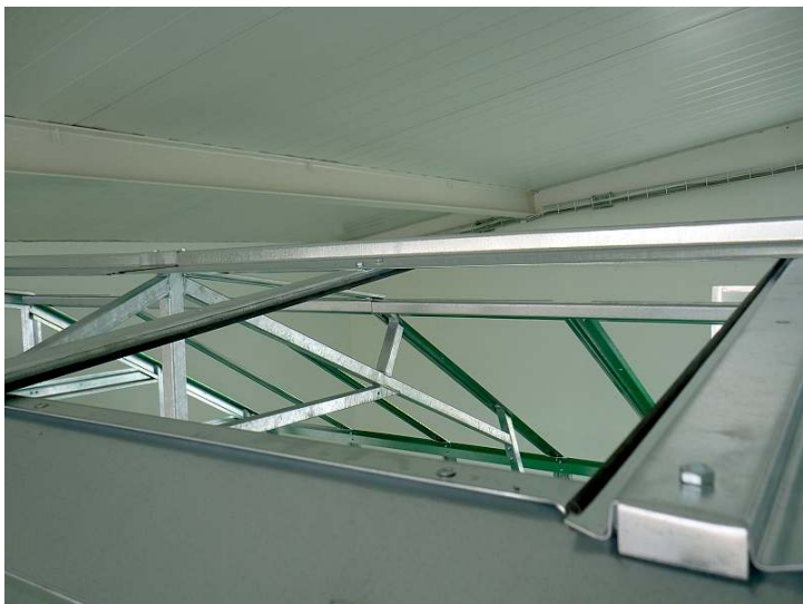
Detail zasklení hřebenové části.
