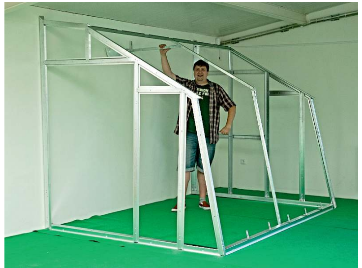
Spojení jácklové výztuhy a čel skleníku střešním spojovacím plechem (poz. 32) Střešní spojovací plech (poz. 32) přichytíme k rohovému sloupku (poz. 8,9) v čele skleníku.
