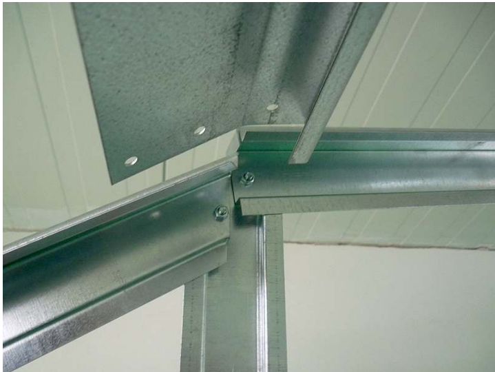
Spojení jácklové výztuhy a čel skleníku střešním spojovacím plechem (poz. 32) Střešní spojovací plech (poz. 32) přichytíme k rohovému sloupku (poz. 8,9) v čele skleníku.
