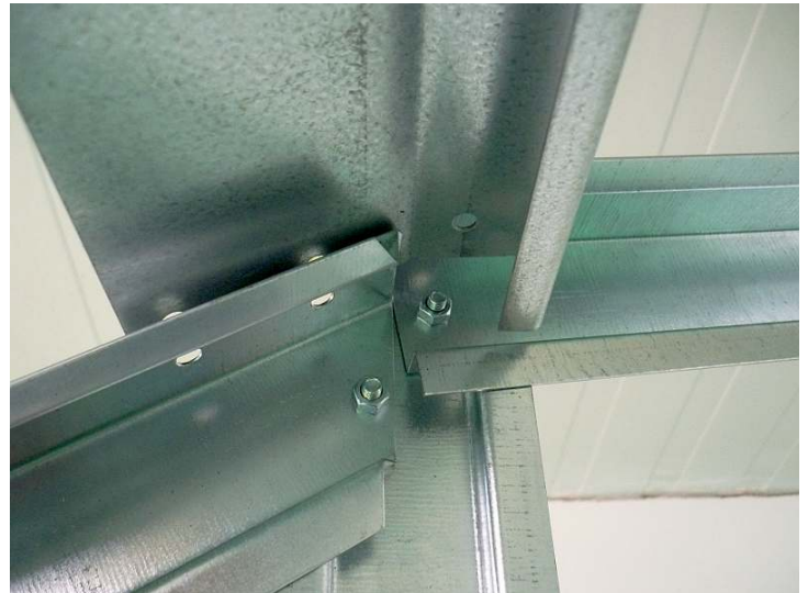
Spojení jácklové výztuhy a čel skleníku střešním spojovacím plechem (poz. 32) Střešní spojovací plech (poz. 32) přichytíme k rohovému sloupku (poz. 8,9) v čele skleníku.
