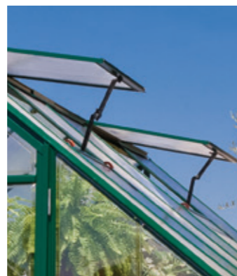
Dvě velká ventilační okna
